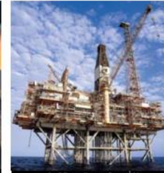
مشأة بحرية وحوض للسفن في الدمام Dammam offshore construction and fabrication yard
